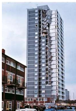
Рис. 1. Разрушение в доме Ronan Point
