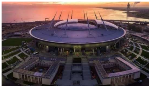
Рис. 3. Стадион «Газпром-Арена» («Зенит-Арена») в Санкт-Петербурге
